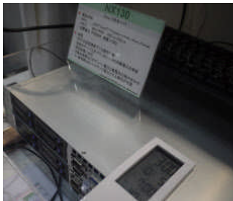
サーバー周辺の温度は47度まで上昇しているが、問題なく動作している
